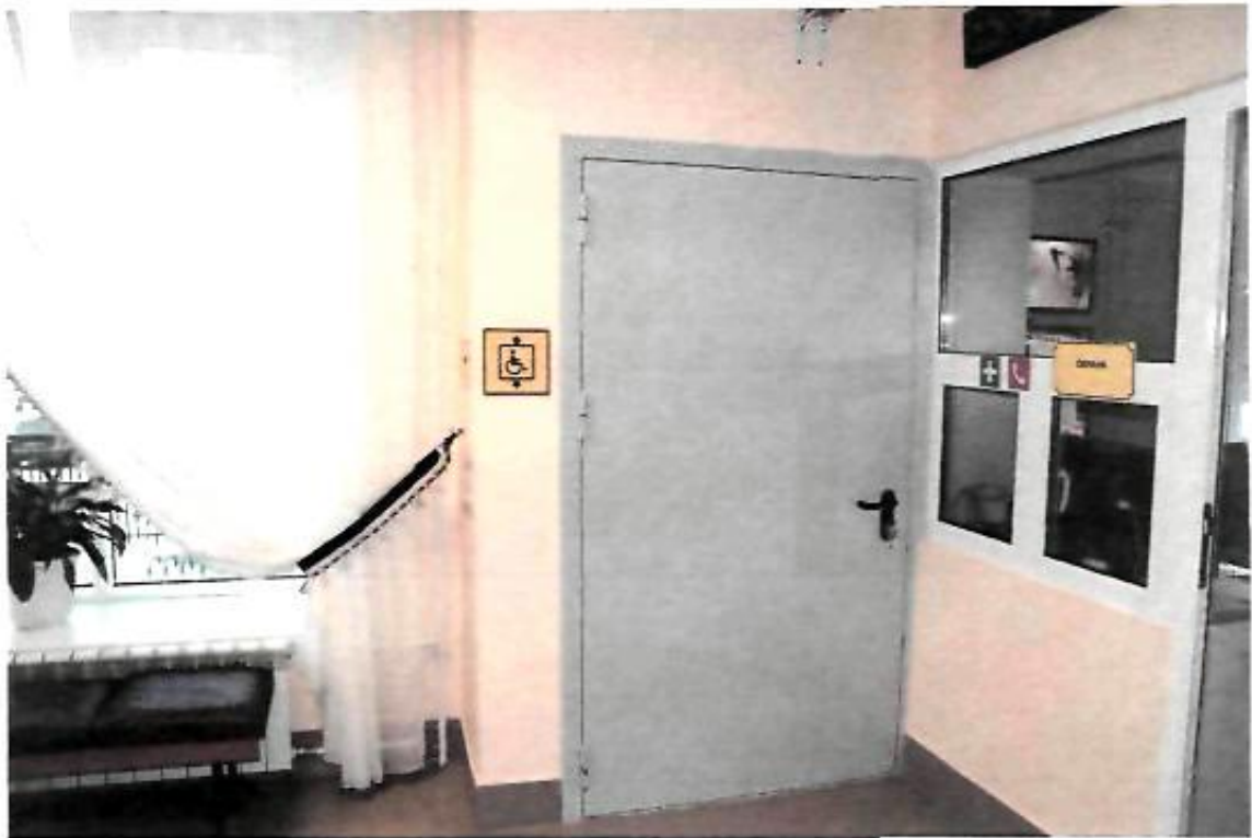
Фото № 4.3. Пути движения внутри здания (дверь)
