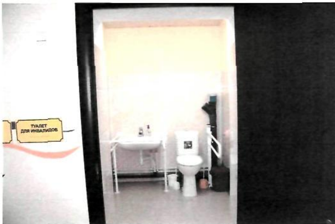
Фото № 7 Санитарно-гигиеническое помещение
